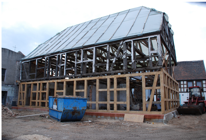
Bild 1: Fachwerkhaus- Instandsetzung und teilweise Erneuerung der hölzernen Tragkonstruktion, Erneuerung des Sockelmauerwerks/Fundament
